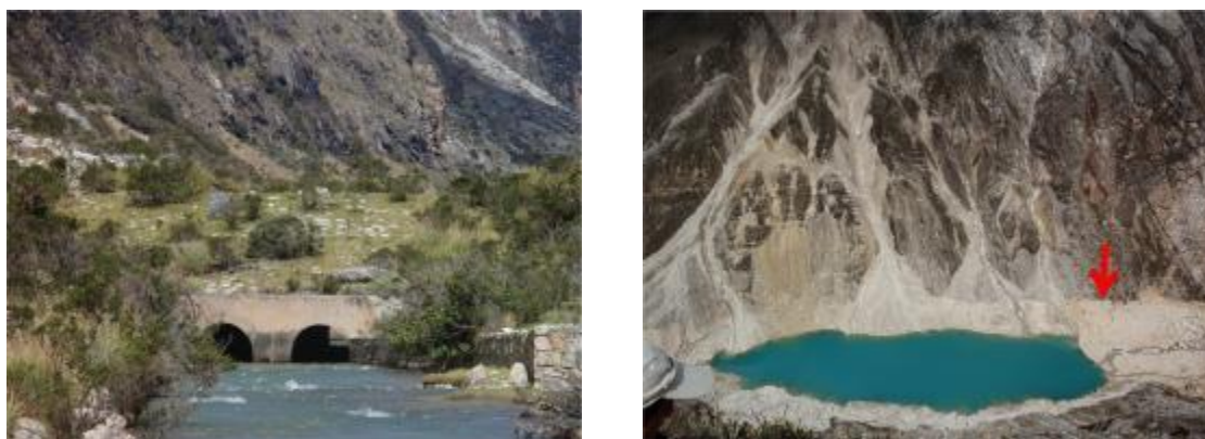
Ilustración 5: Obra de desagüe del dique de tierra de la Laguna Jatuncocha (Foto izquierda: César Portocarrero) e inestabilidades de ladera y marcas del antiguo nivel de la Laguna Artisón baja (Foto derecha: César Portocarrero)
