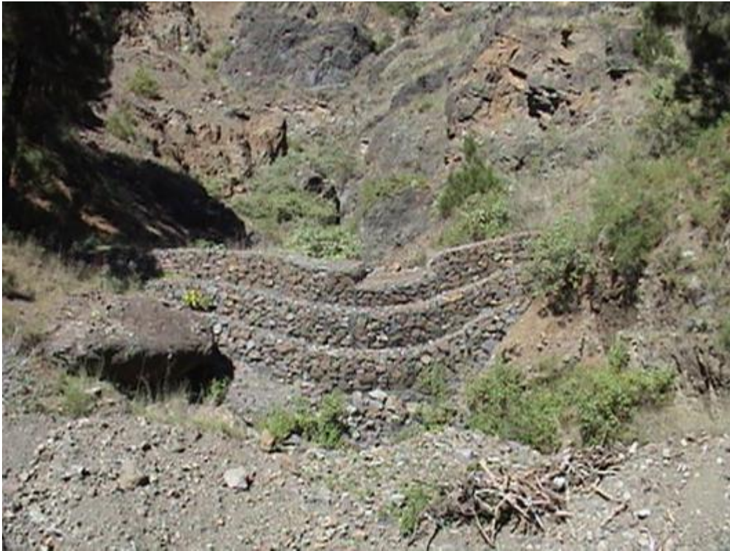
Ilustración 3: Ejemplo de un dique de gaviones para la retención de sedimentos y laminación durante avenidas.
